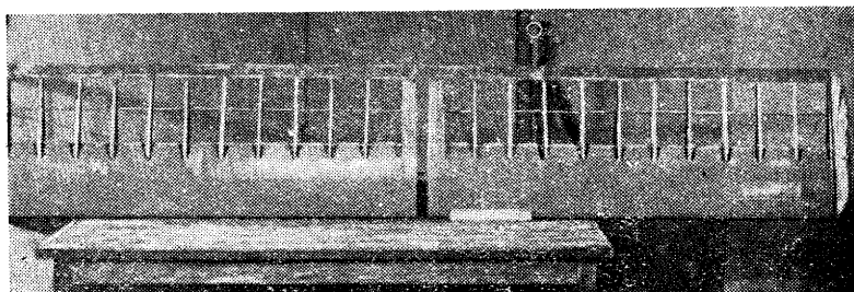
Фиг. 3. Отсек лопасти перед обтяжкой полотном
